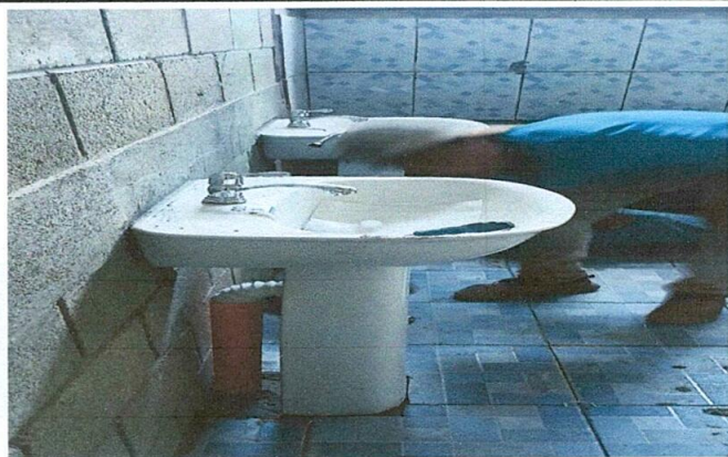
Foto 1: Mejoramiento de reparación de baños.
